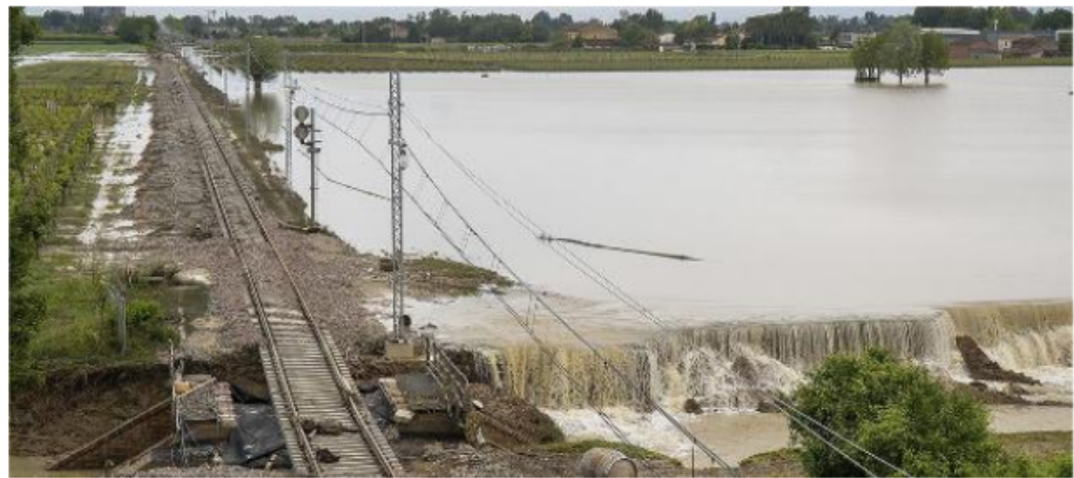
La rottura a Boncellino e, a sinistra, la ricostruzione dell'argine che ha ceduto a Cà di Lugo (foto Zani)
