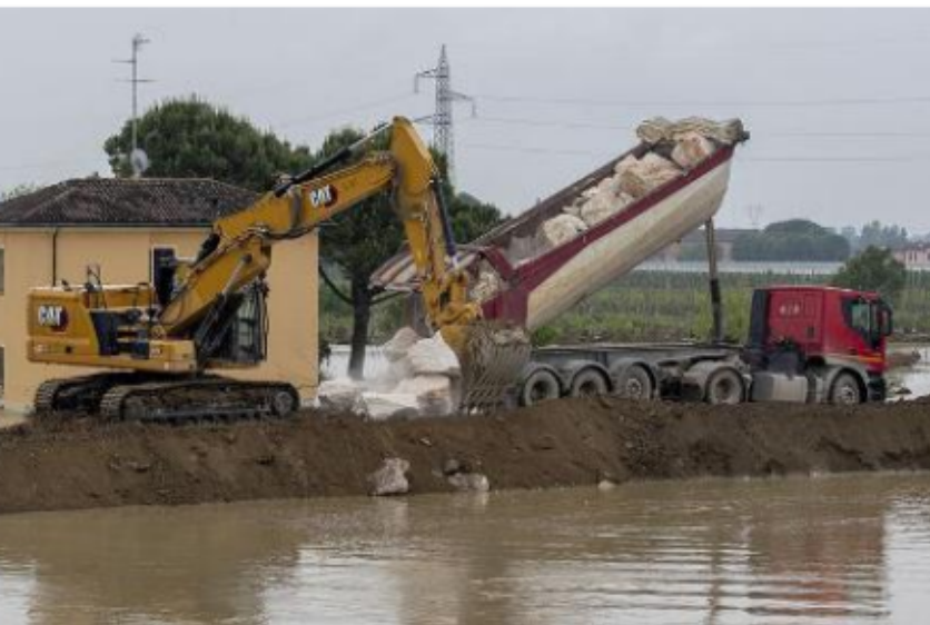
La rottura a Boncellino e, a sinistra, la ricostruzione dell'argine che ha ceduto a Cà di Lugo (foto Zani)
